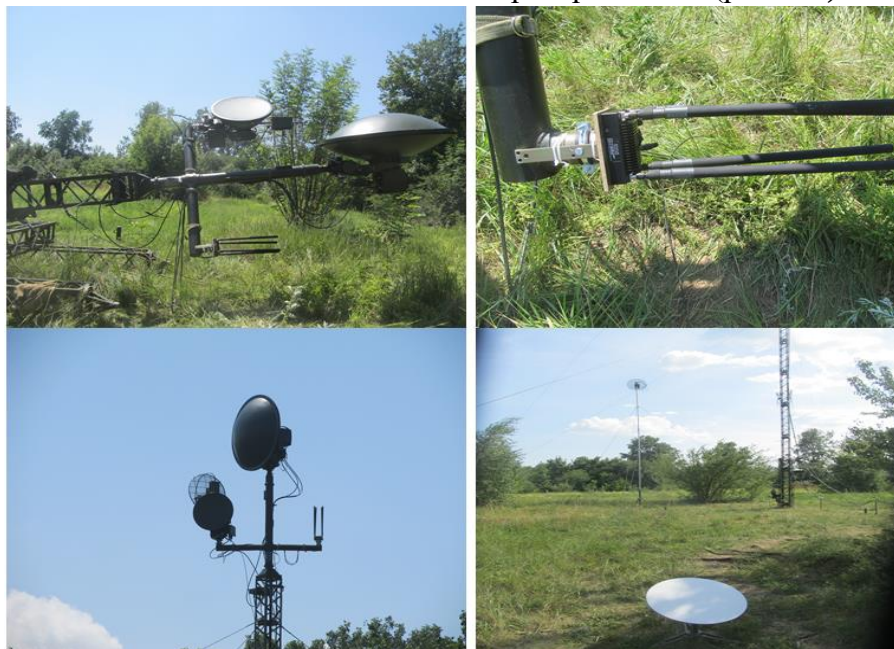
Рис. 4.2. Встановлення радіостанції на щоглу
